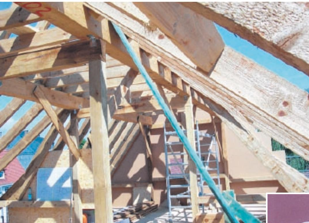
Der Keller, das Erdgeschoss und das Gewölbe waren bei dieser Immobilie in einem akzeptablen Zustand, das Fachwerk hingegen war nicht mehr zu sanieren und musste abgerissen werden. Aus statischen Gründen errichtete die Schreinerei Kolar erneut ein Fachwerk auf dem Erdgeschoss. Dabei wurde der Rohbau hochgezogen und mit Dämmplatten aus Holzfasern gedämmt. Die Holzfaser-Dämmung wirkt sehr gut und erzeugt ein angenehmes Wohnklima. Das Dach wurde schließlich mit Biberschwanz gedeckt.
